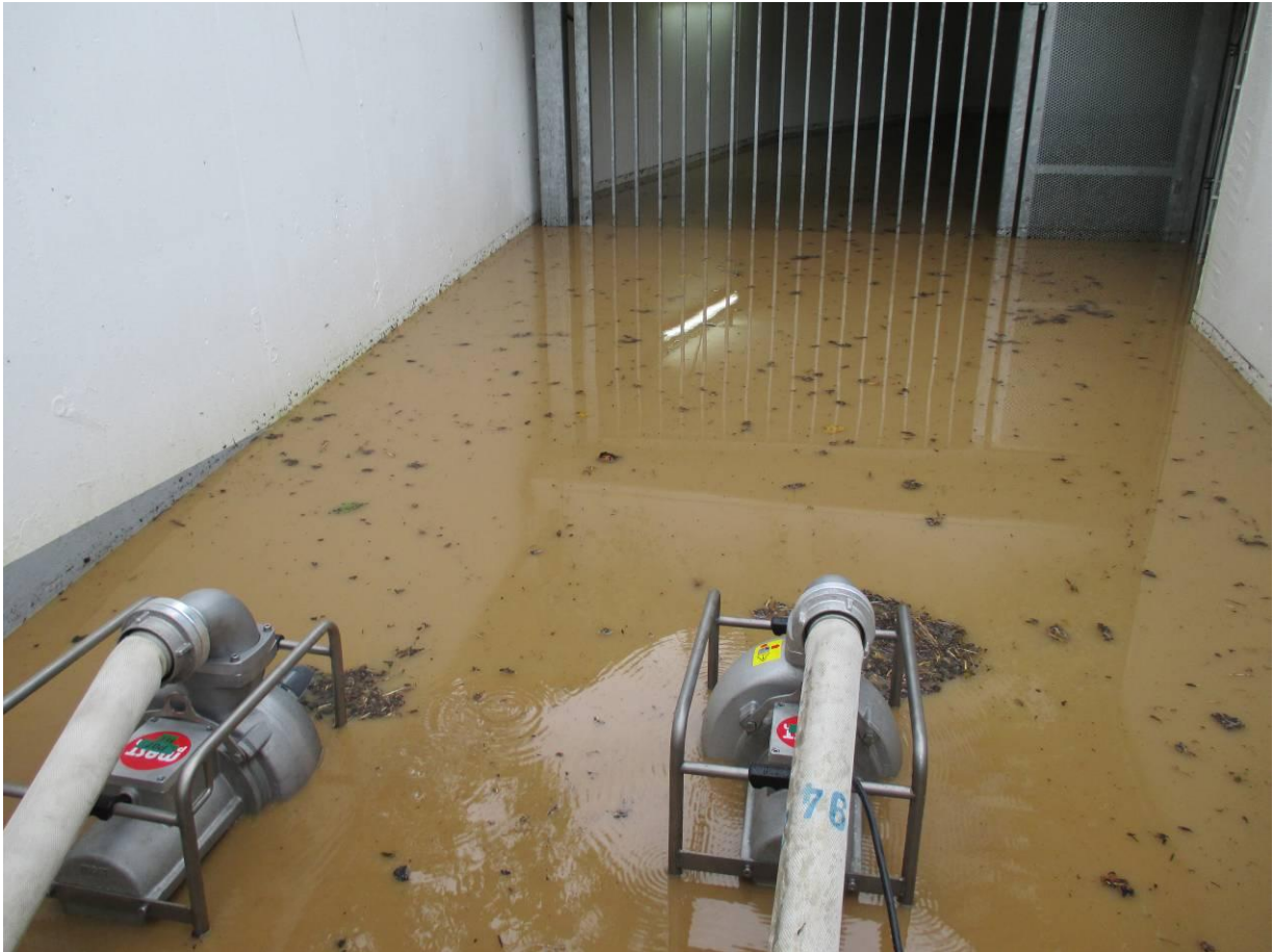
Einsatz der Hochleistungspumpen mit einer Leistung von ca. 1.500 Litern/Minute
