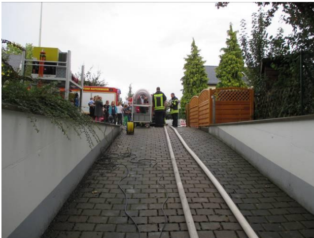
Einsatz der Hochleistungspumpen mit einer Leistung von ca. 1.500 Litern/Minute
